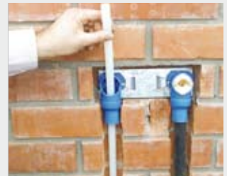
Introducir el tubo Pex-A
