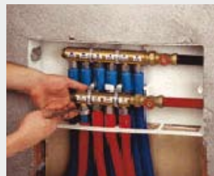
Instalar los colectores
